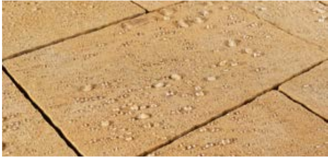
POVRCH DLAŽBY S ÚPRAVOU DEP
